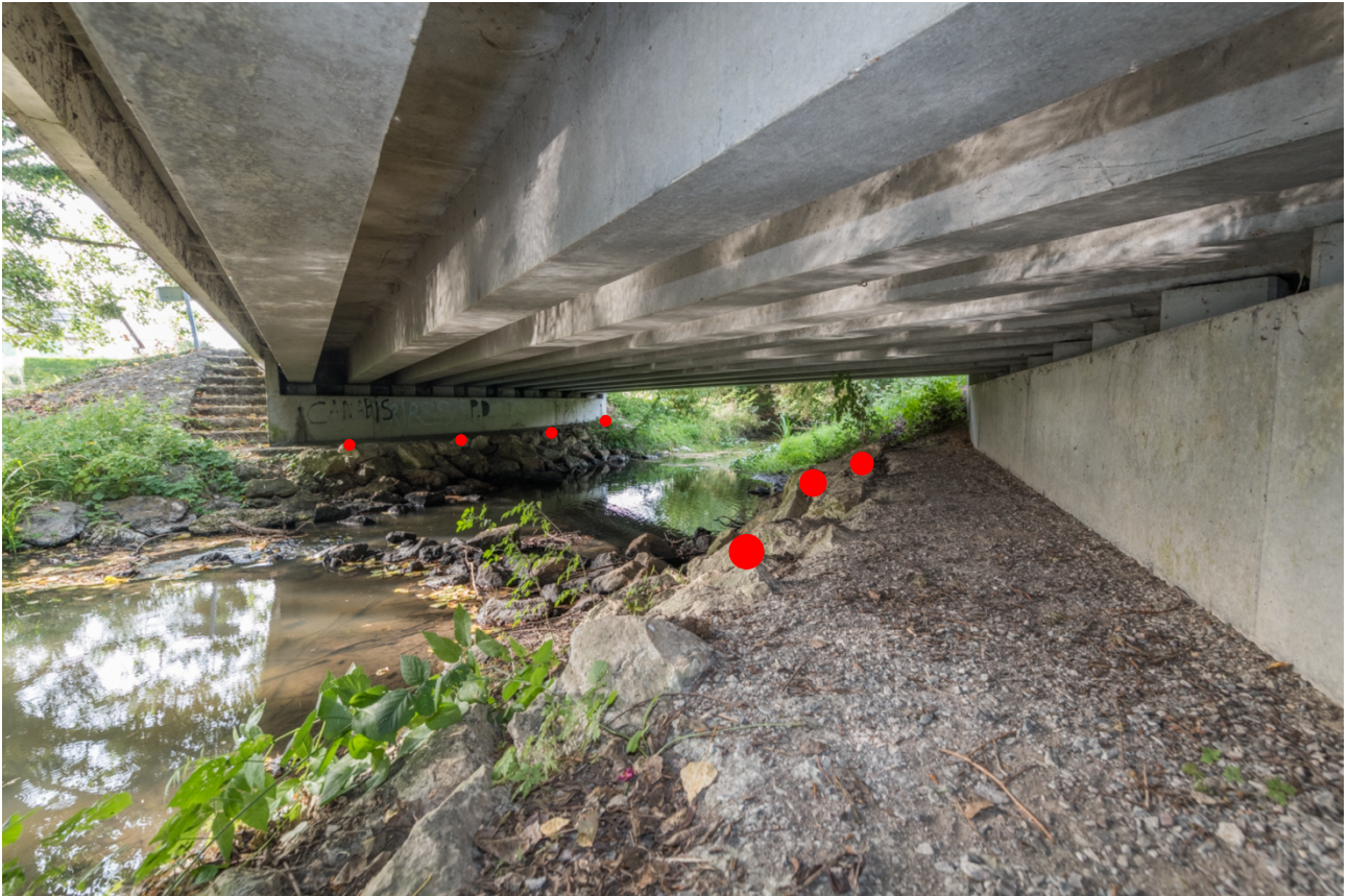
Figure 12 Ouvrage propice à la Loutre d'Europe sur la Fare à Villiers-au-Bouin. Les banquettes de part et d'autre du cours d'eau poursuivent la continuité de berge et permettent à la Loutre de cheminer sous l'ouvrage à pieds secs. Les blocs rocheux situés à la base des piles du pont sont des places de marquage parfaites (les épreintes sont signalées en rouge) (E. Sansault, 2018).
