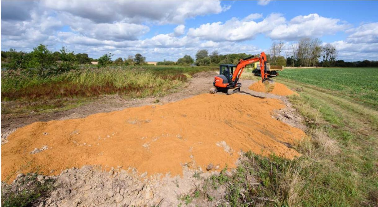
Figure 5 Le sable est étalé sur toute la surface de la dune de pont (ES-14/09/17).
