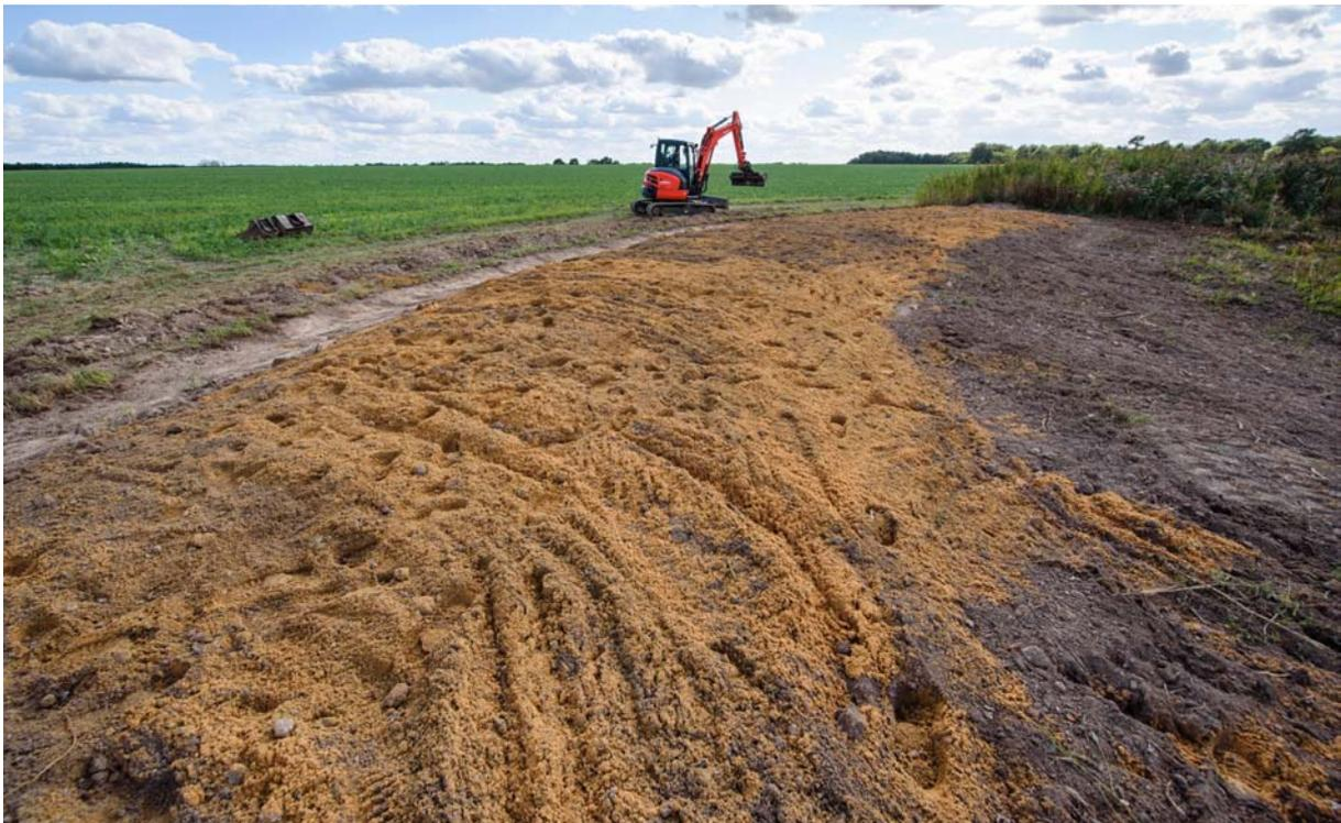
Figure 6 Mélange du sable de la terre et curage du fossé de drainage (ES-14/09/17).
